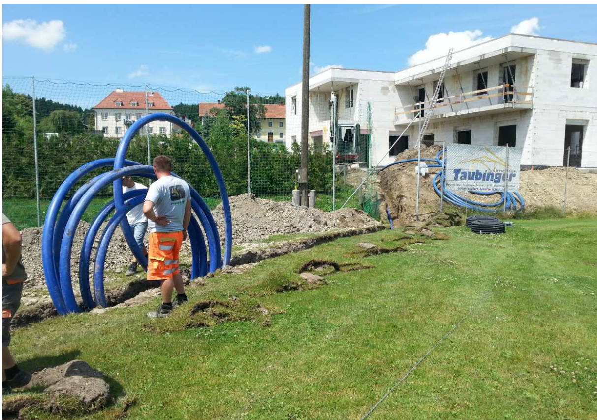
Abb. 8: Verlegung der Zu/Ableitung für Energie aus Abwasser
