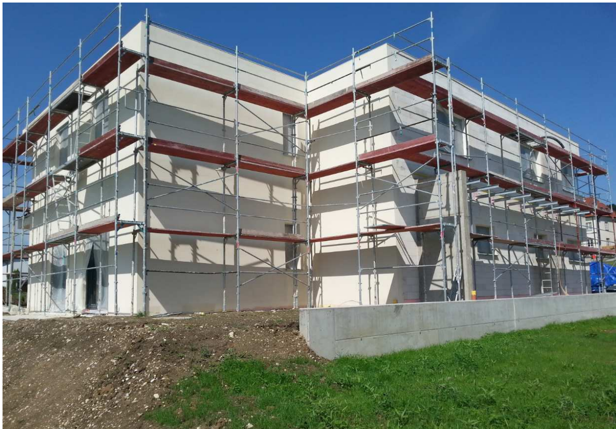
Abb. 9: Fassadenarbeiten ohne VWS
